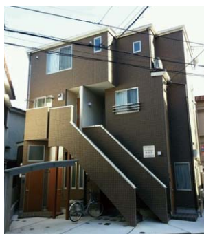
賃貸併用住宅の提案も積極的に行っている。オーナーに高い居住環境を提供しつつも、投資用都市型アパート事業のノウハウを生かし、建築コストを抑えた収益性の高い住宅を供給
